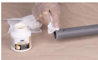
5 / Dégraissez au décapant.
